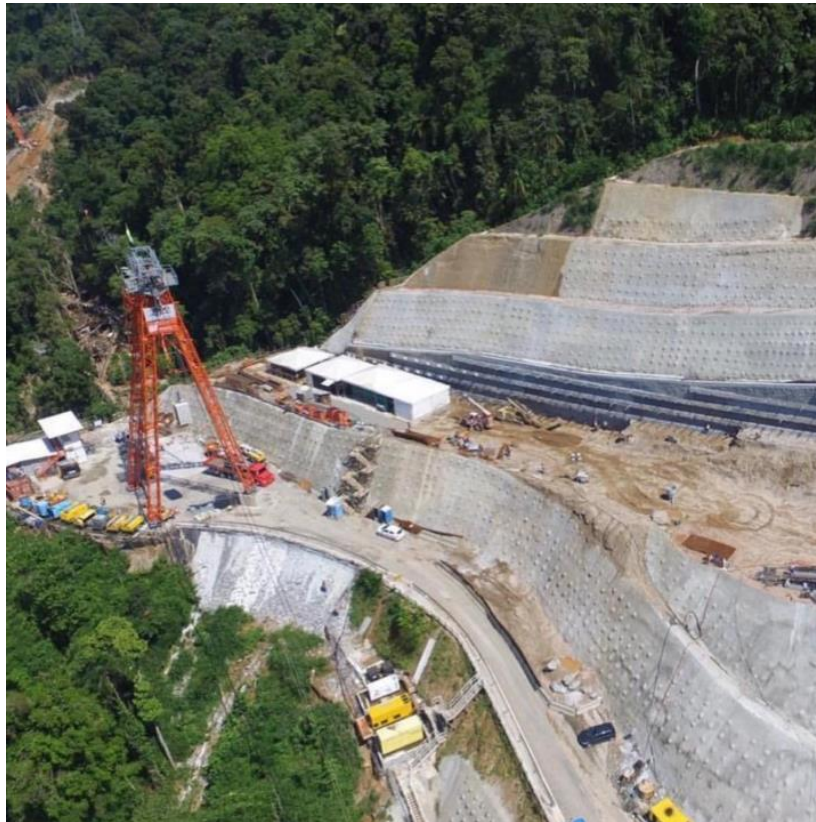
Figura 7 - Vista Aérea da plataforma do guindaste, caminho de serviço e contenção definitiva ao fundo sendo executada (foto de abril de 2019).
