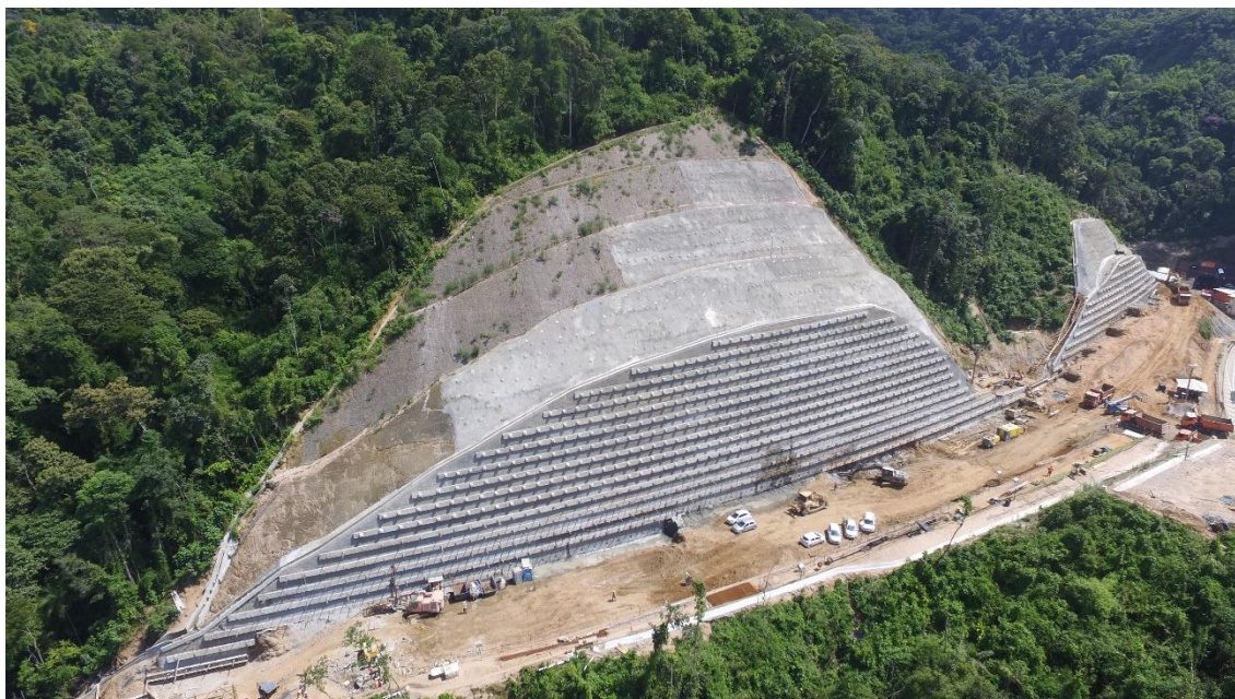
Figura 11 - Vista Aérea das cortinas de contenções em execução (abril de 2019).
