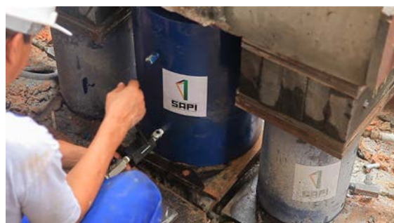
Figura 17. Macaco instalado no pilar
