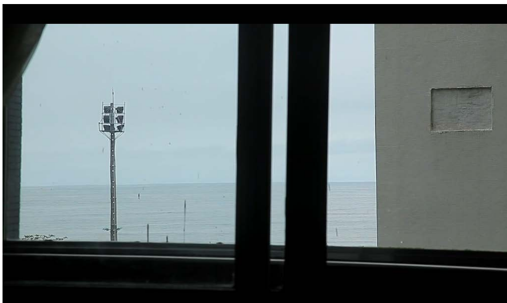
Figura 4. Linha do horizonte vista através de uma janela de um prédio inclinado
