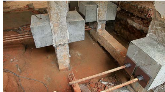
Figura 13. Construção de consoles
