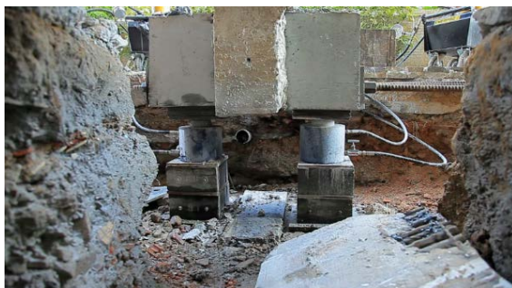
Figura 16. Nicho aberto para colocação do Macaco para levantar o pilar
