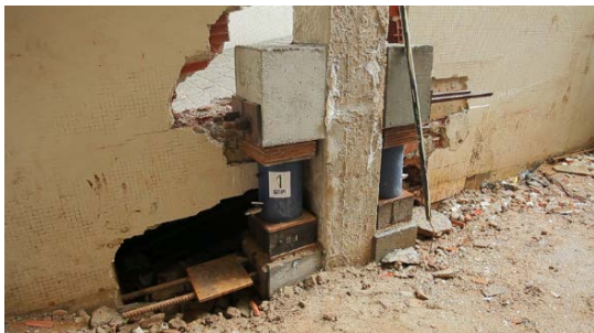
Figura 14. Macacos instalados para abrir um consoles
