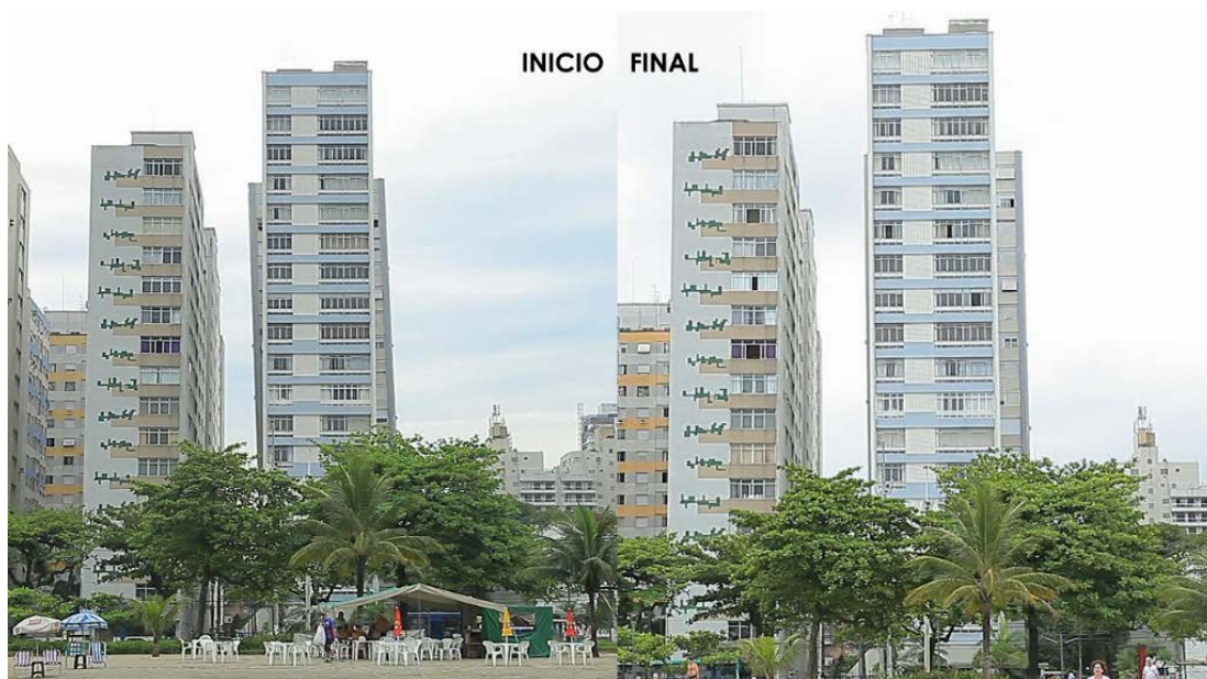
Figura 18. Condomínio Núncio Malzoni antes e após o reaprumo do Bloco B
